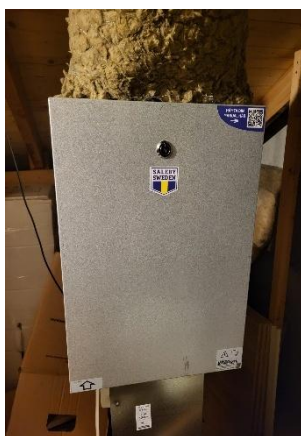
Bild 2 Luckan som ska öppnas.
